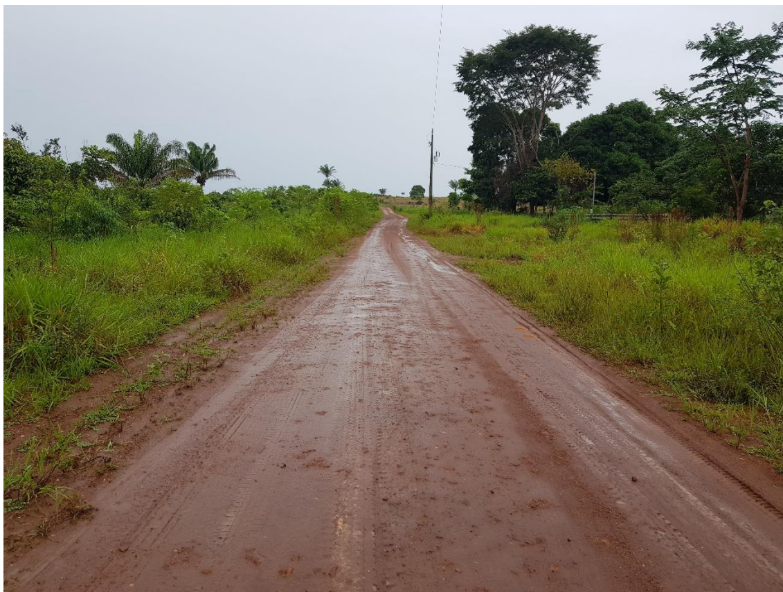
ESTRADA ACESSO PONTE RIO ENGANO
