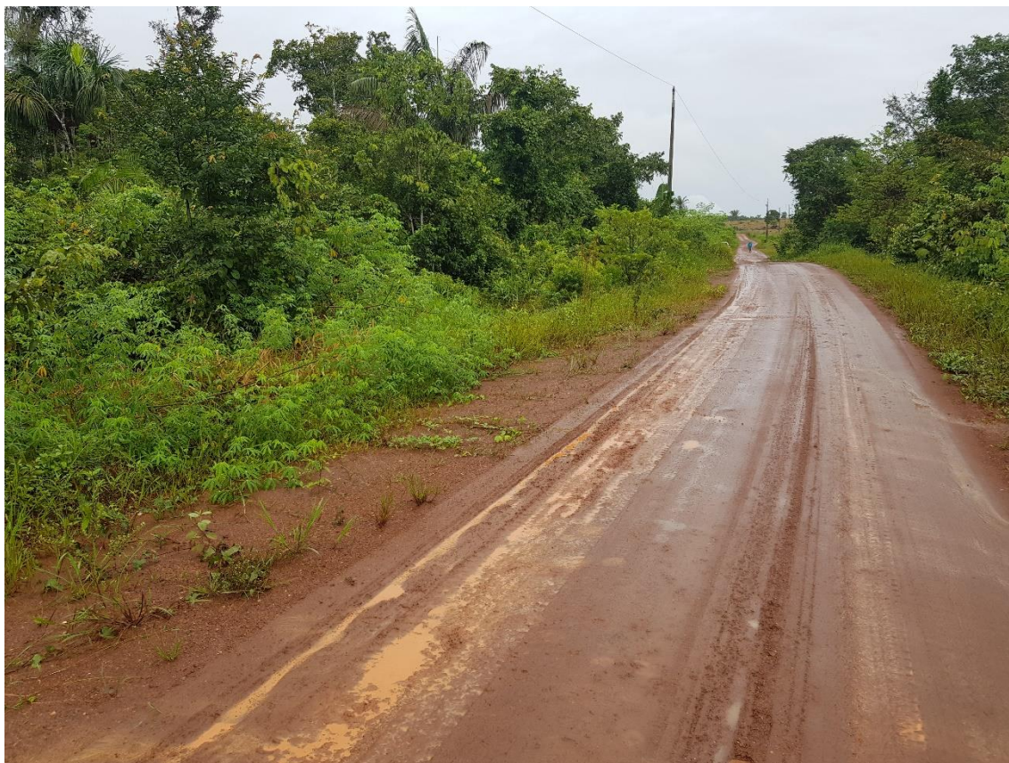
ESTRADA ACESSO PONTE RIO ENGANO
